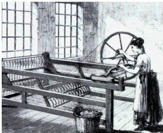
La “spinning Jenny” inventata dall'inglese James Hargreaves nel 1764, antesignana delle macchine per la filatura. I fusi girano grazie a un cilindro azionato manualmente con la grande ruota a puleggia.
